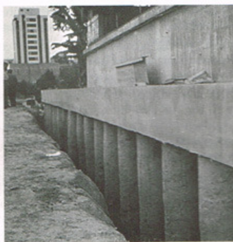
Foto 9.11 - Muro de contenção com hélice contínua
